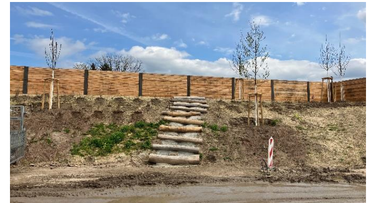
Dichte Bepflanzung des Bogenwalls
