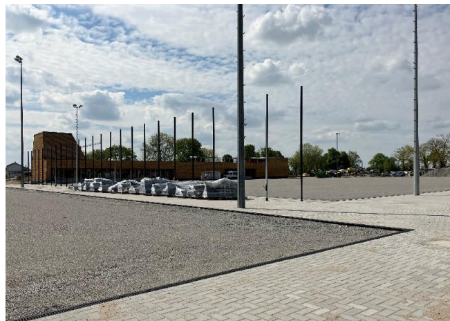
Pflasterung der Haupt-Wegeverbindungen
