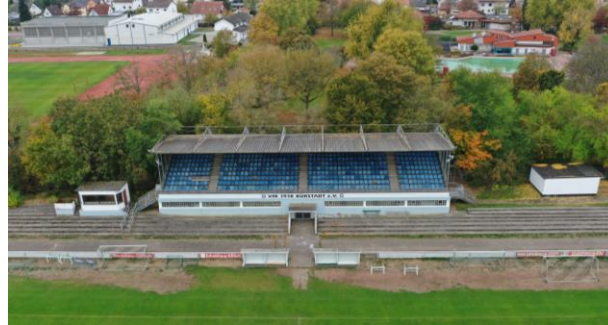
Abbruch Tribüne Juli 2019
