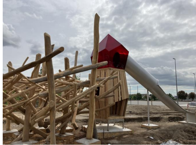
Einbau des ersten Spielgerätes „Kukuksnest“
