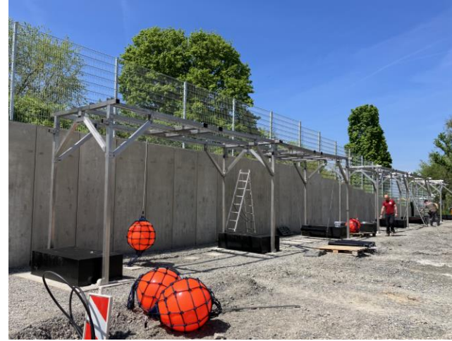
Einbau des Ninja-Parcours – erstes Outdoor-Ninja in Hessen
