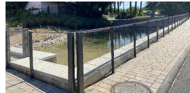
Abb.26 Bildbeispiel: Geländer-/ Absturzsicherung Planung: SHK
